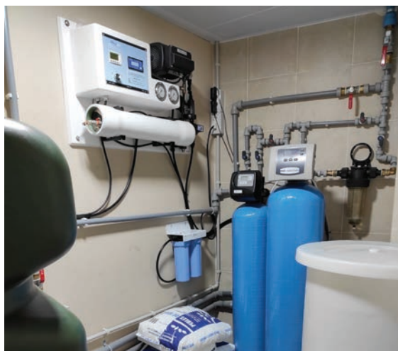
Sistema de osmosis para la esterilización del agua.
